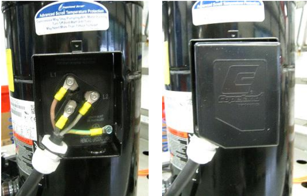
Figure 18 : Installation correcte avec presse-étoupe, boîtier électrique en IP21
