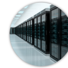
机房空调发展趋势
