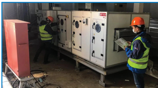
天加为雷神山现场安装医用空调设备
