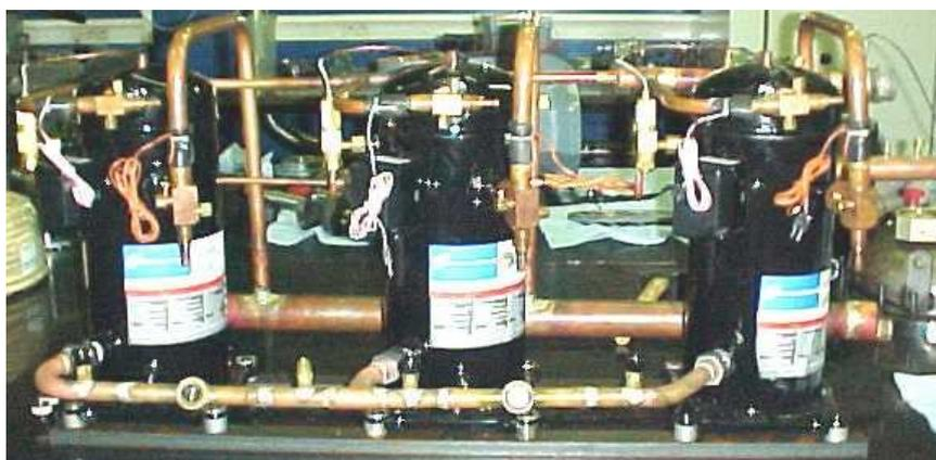
Рис. 2: Параллельная работа спиральных компрессоров
